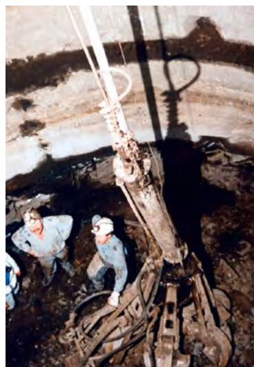
Hlubicí práce při výstavbě Dolu ČSM.
